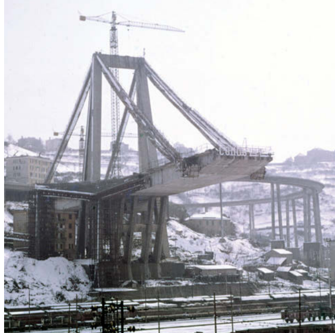
Il ponte Morandi in costruzione - anni '60 - Fondazione Ansaldo - Fondo Publifoto
