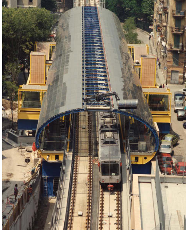
Stazione firm della metropolitana in costruzione - anni '80 - Fondazione Ansaldo - Fondo Ansaldo
