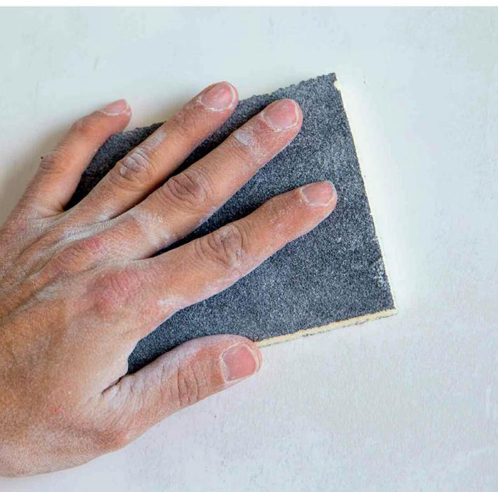
La carteggiatura dello stucco va fatta con mano molto leggera e con l'aiuto di un tampone o di una spugna abrasiva; la grana va scelta in base all'aspetto del muro, per non correre il rischio che la zona stuccata risulti molto più liscia del muro attorno a essa e risulti evidente, quando lo scopo è invece quello di restituire uniformità.
